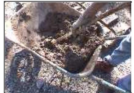
mélange terre/fibres (doc.Le Gabion)
