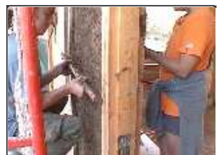
lissage (doc.Le Gabion)
