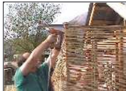
coffrage perdu roseaux (doc. Le Gabion)
