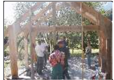
ossature bois (doc. Le Gabion)
