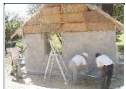
pose de l'enduit stage Le Gabion (doc. Le Gabion)
