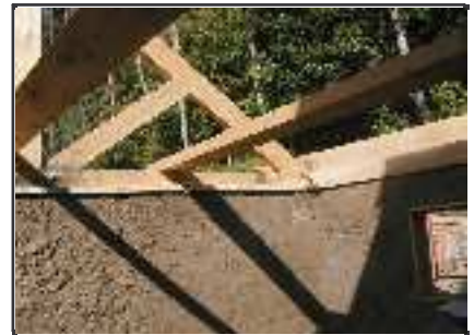
enduit terre ragréage (doc.Le Gabion)
